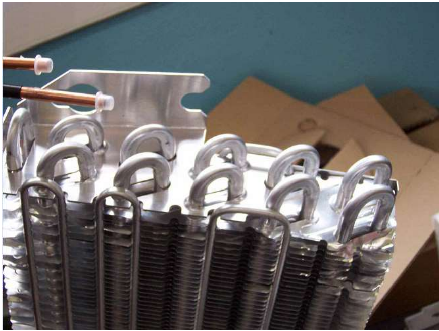
Figura 44: Esempio di batteria alettata
