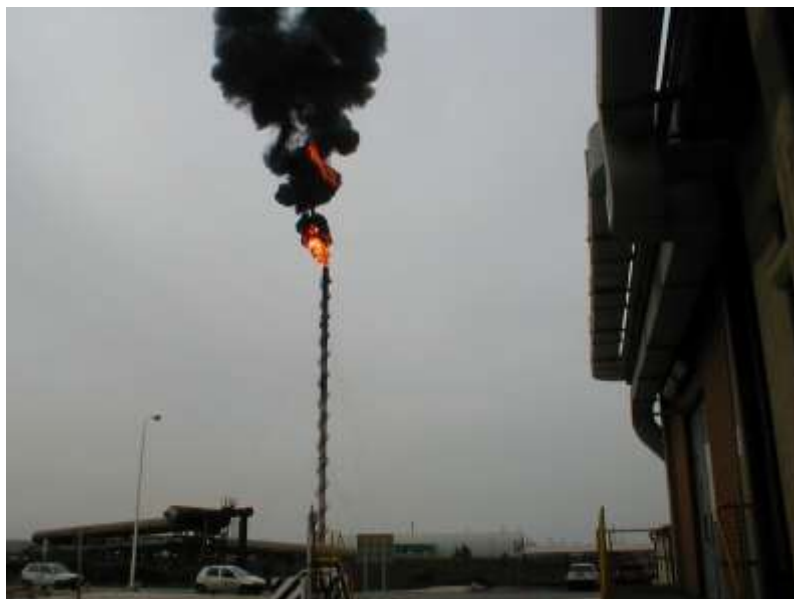
Figura 88: Formazione di un pennacchio in una torcia di raffineria
