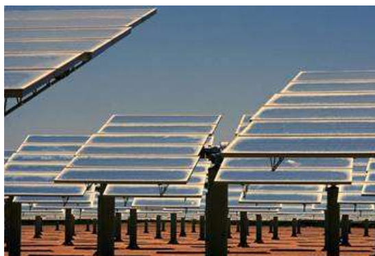
Figura 105: struttura standard di un eliostato
