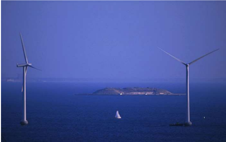
Figura 145: Generatori eolici in mare – torre da 133 m e diametro di 122 m
