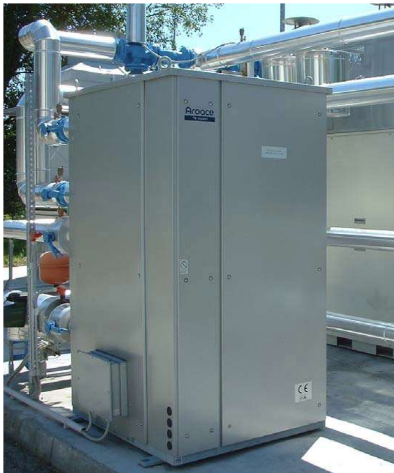
Figura 160: Vista di un assorbitore alimentato ad acqua calda con potenza frigorifera da 35 kW
