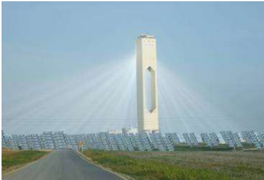
Figura 101: Impianto solare termodinamico a torre centrale
