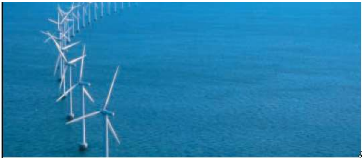
Figura 144: Campo di generatori eolici in mare
