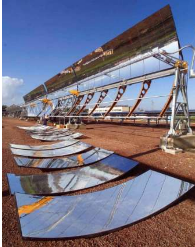
Figura 97: Specchi e collettori in fase di montaggio (fonte Enel)
