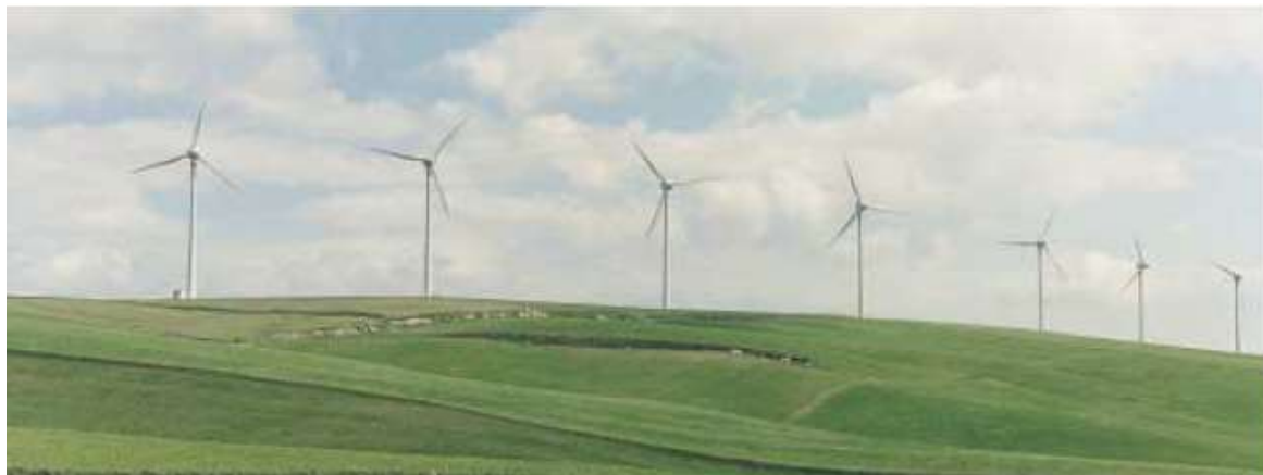
Figura 143: Campo di generatori eolici su terraferma
