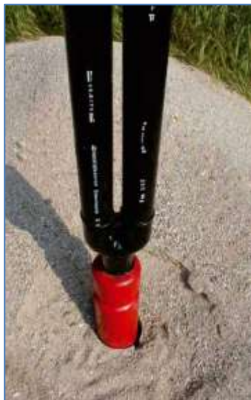
Figura 240: Esempio sonda geotermica verticale
