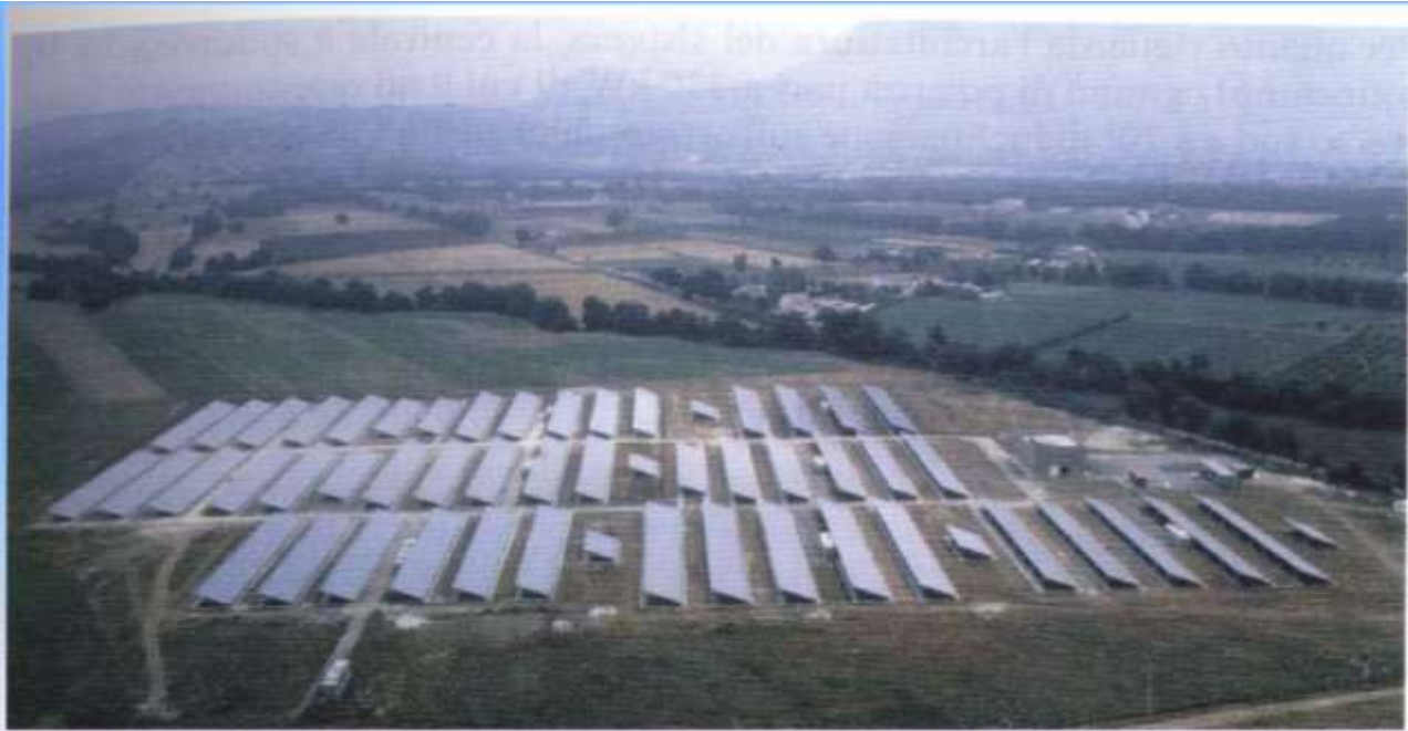
Figura 136: Impianti da 3.3 MWep di Campo Serre (Salerno)
