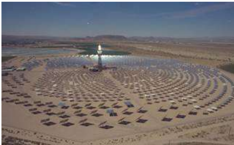
Figura 102: Impianto solar two in esercizio negli anni 90 (fonte NREL)
