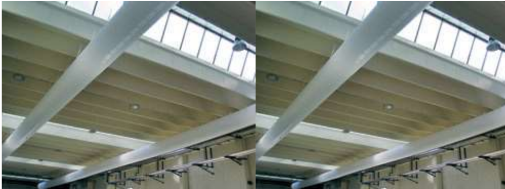
Figura 134: Distribuzione dell'aria con canali in tessuto
