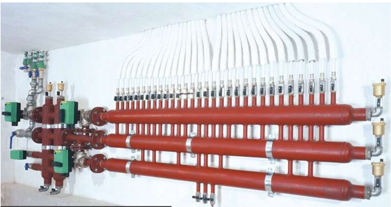
Figura 64: Esempi di collettori di centrale
