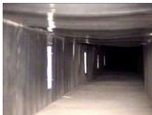
Figura 149: Ispezione di canali d'aria
