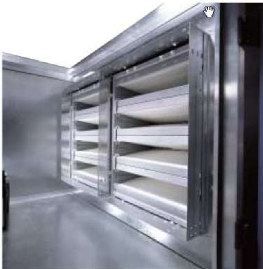
Figura 280: Sezione filtrante di una CTA
