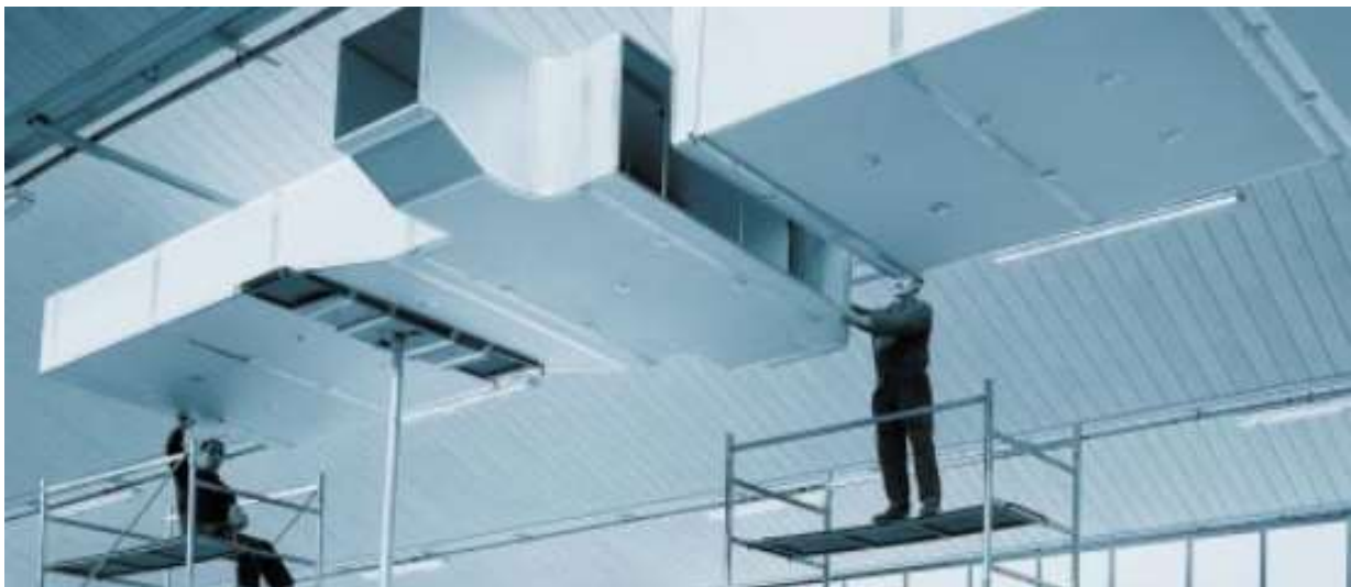
Figura 1: Ingombro dei canali d'aria
