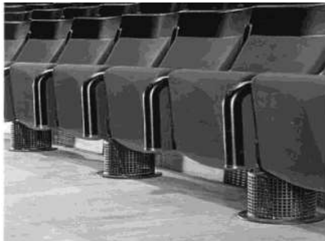
Figura 408: Diffusori a dislocamento sotto poltrona
