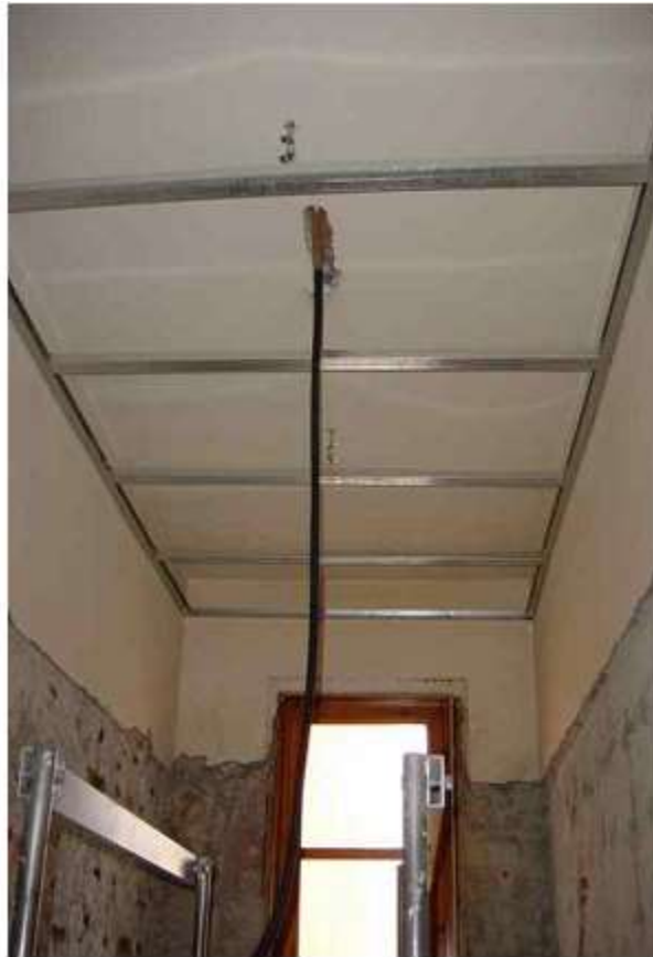
Figura 191: Controsoffitto interno a protezione dell'isolante
