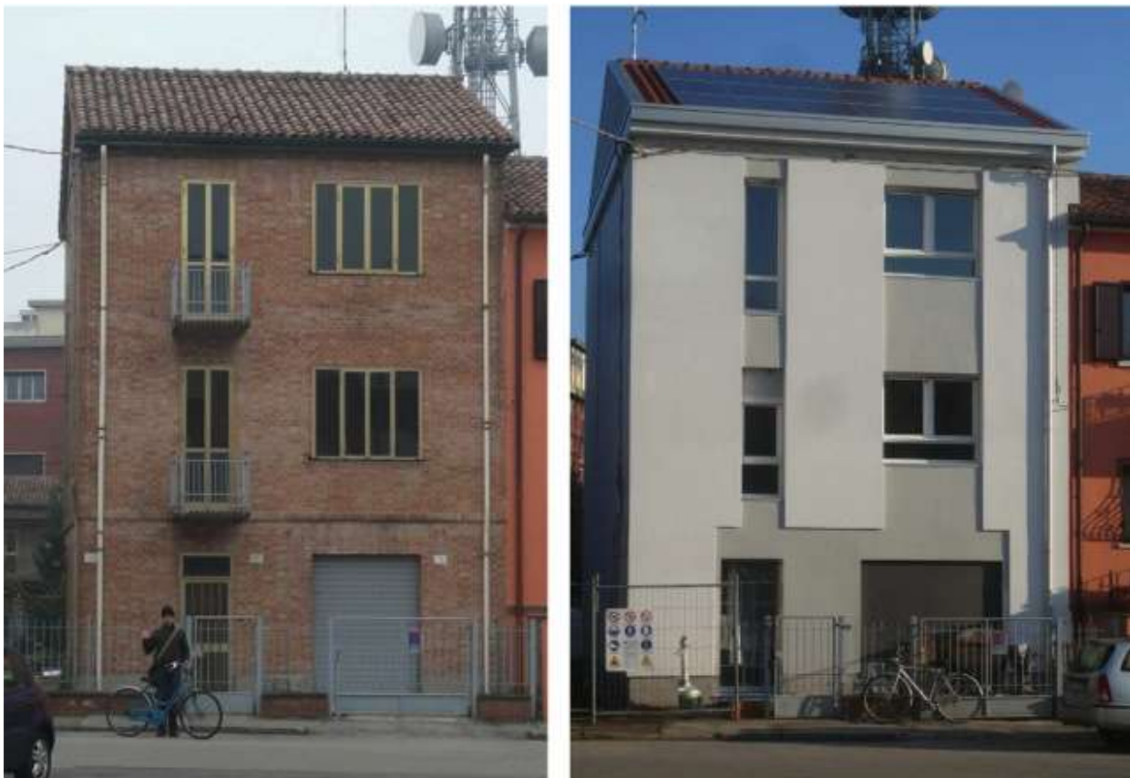
Figura 221: Esempio di riqualificazione energetica
