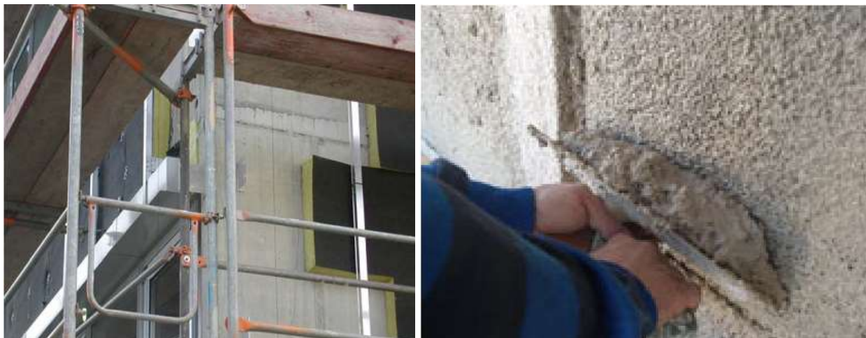
Figura 195: Applicazione dell'isolamento a cappotto e intonaco isolante
