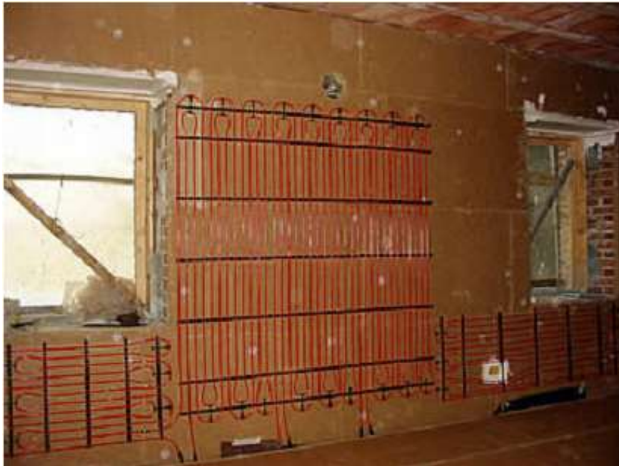
Figura 207: Inserimento di pannelli radianti a parete
