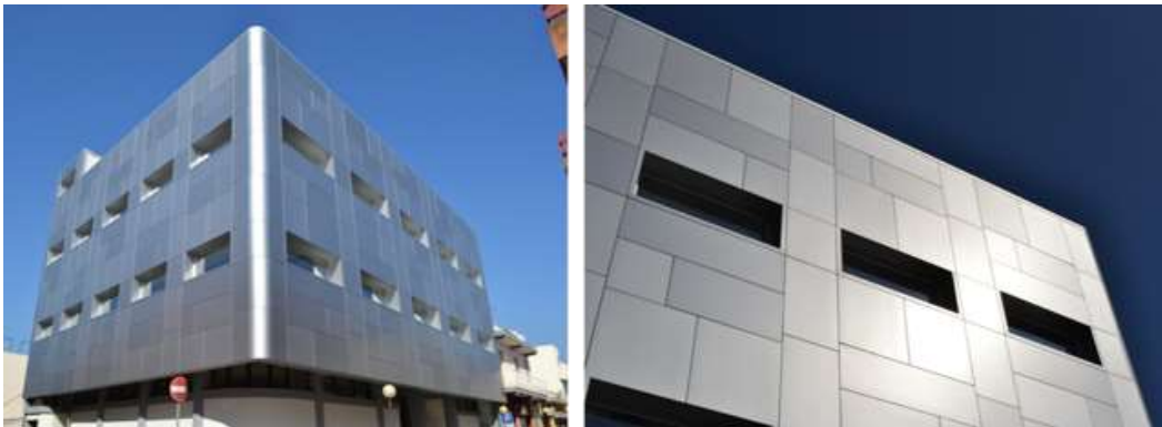
Figura 225: Viste dell'edificio post-intervento
