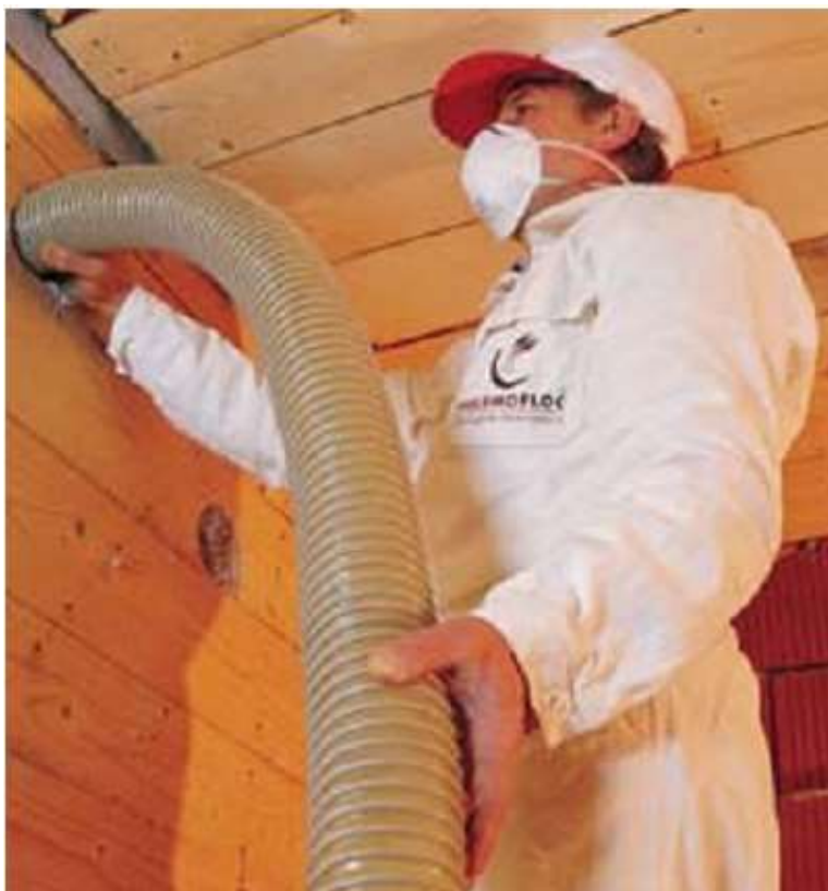
Figura 197: Inserimento di schiuma polimerizzante nell'intercapedine di una parete.
