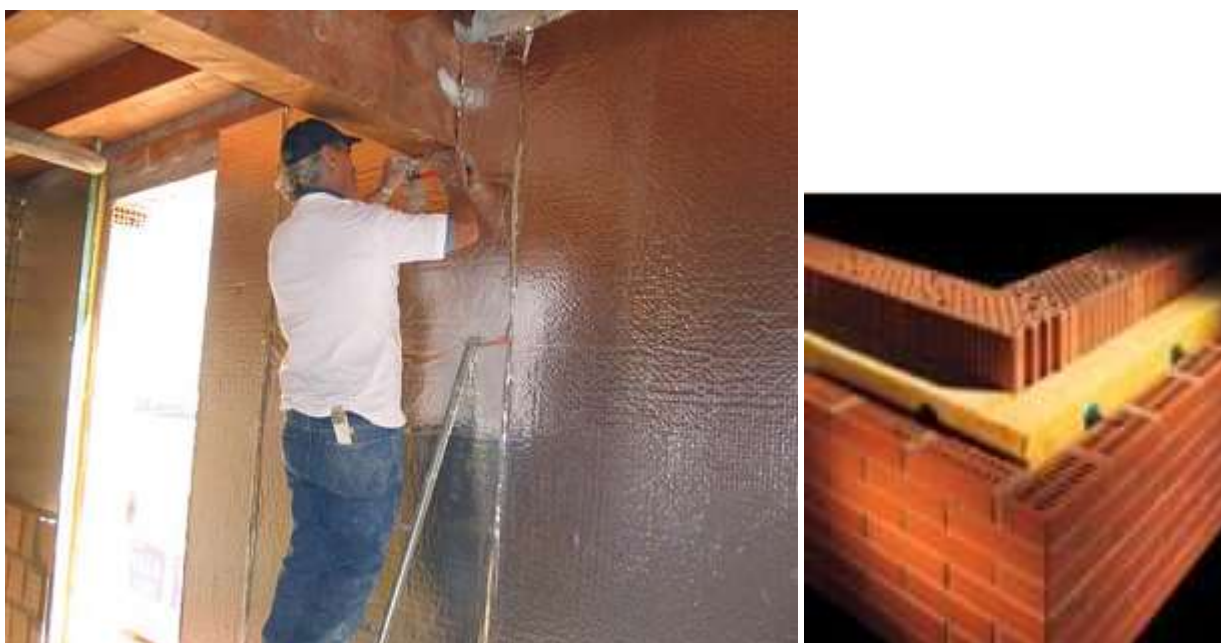
Figura 198: Applicazione di pannelli isolanti all'interno delle pareti
