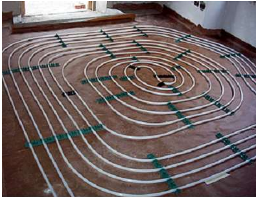
Figura 205: Pannelli radianti a pavimento
