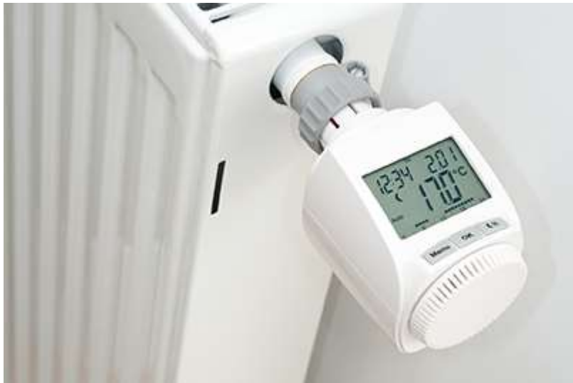
Figura 401: Contabilizzatore di calore applicato ad un radiatore
