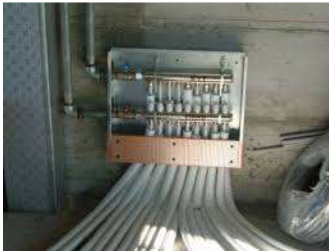
Figura 25: Esempio di installazione dei collettori complanari
