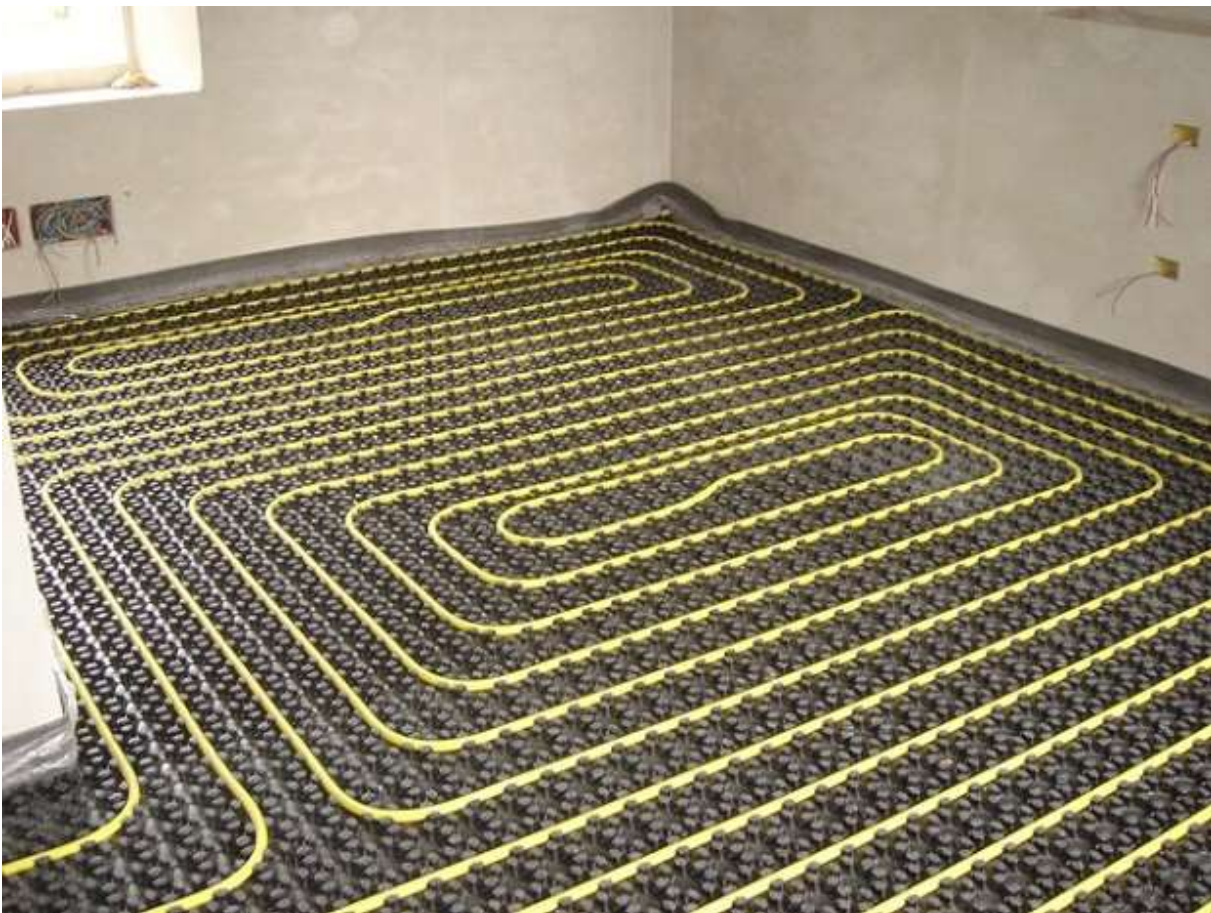
Figura 264: Posa in opera di pannelli radianti
